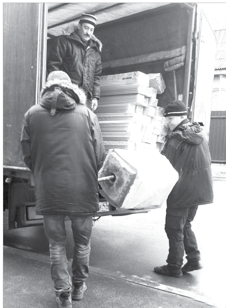
Разгрузка стройматериалов для ремонтных работ
