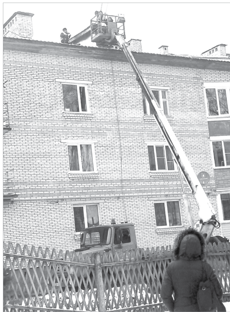
Чистка крыши дома от снега
